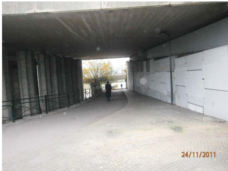
Passerelle existante traversant toutes les infrastructures autoroutières et bretelles Signalisation verticale (directionnelle) Eclairage (permanent)
