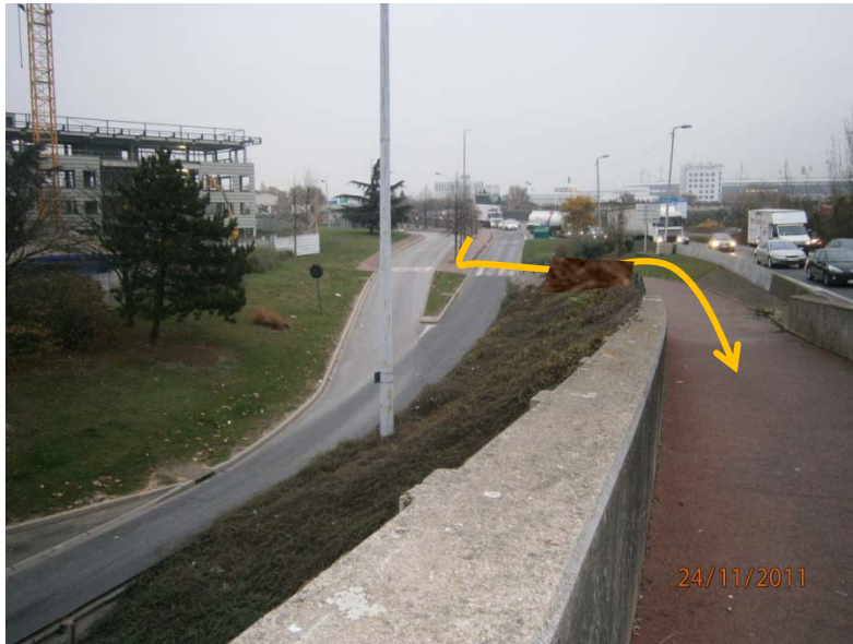
Rampe accès passerelle existante Signalisation verticale (directionnelle) Eclairage
