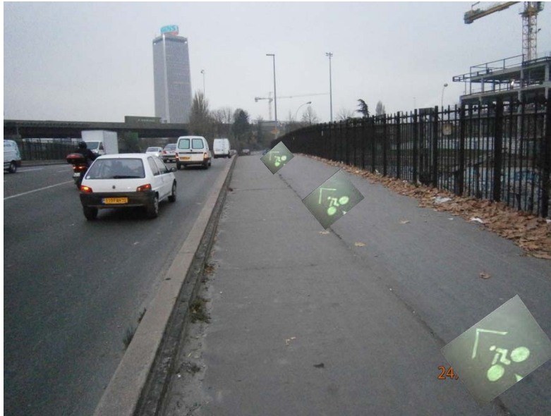
Bd Anatole France, sur le pont de chemin de fer : Marquage Piste sur trottoir (très peu fréquenté)
